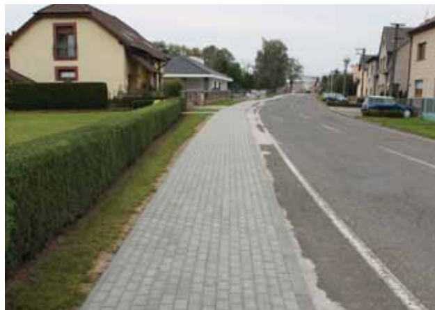
Oprava chodníku na ul. Masarykova - nový stav
