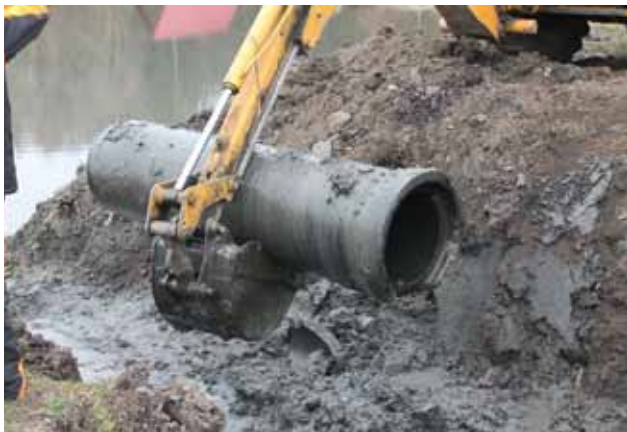
Oprava kanalizace v Restě - starý stav
