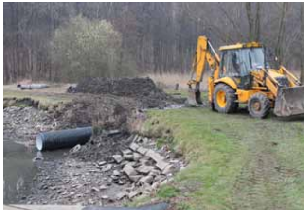
Oprava kanalizace v Restě - nový stav
