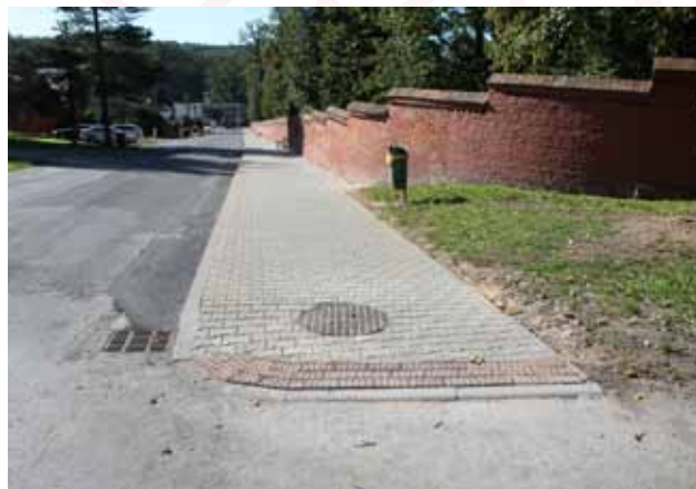
Oprava chodníku na ul. Komenského - nový stav
