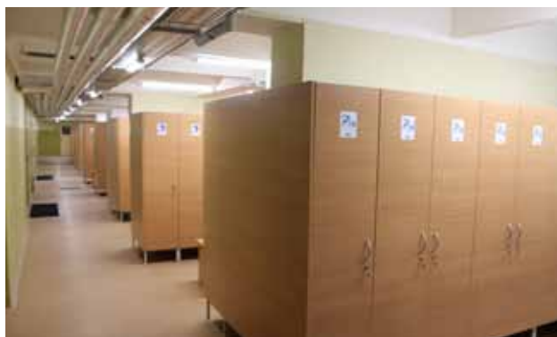
Rekonstrukce šaten - nový stav
