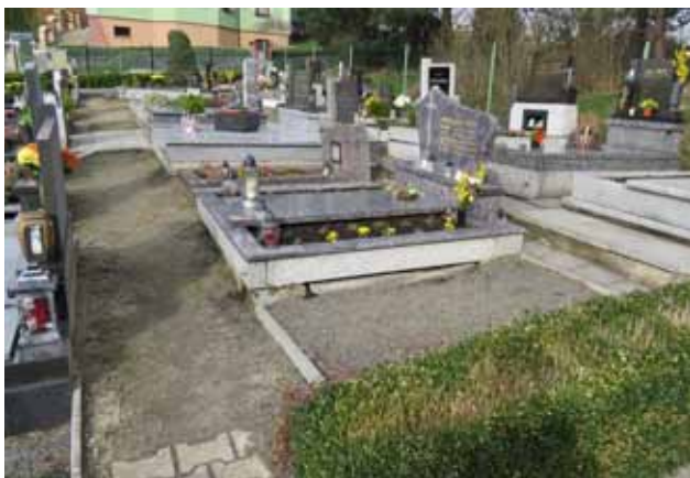
Oprava hřbitova - starý stav
