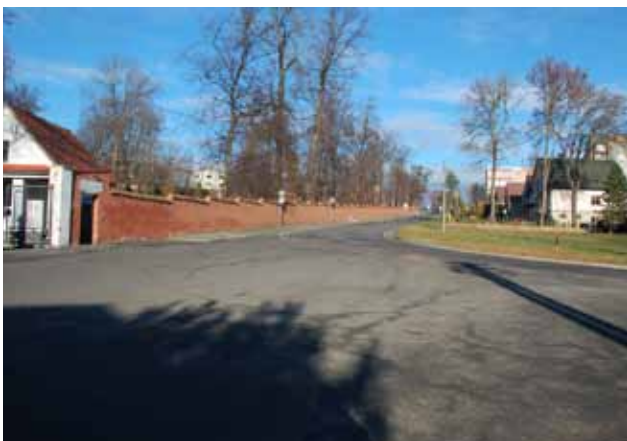
Rekonstrukce křižovatky - starý stav
