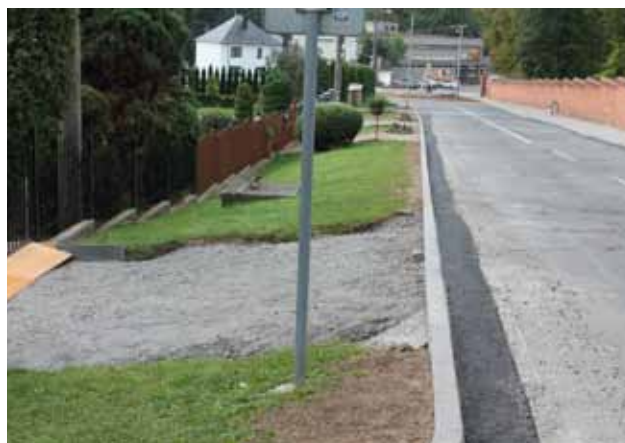
Výměna obruby na ul. Komenského - nový stav
