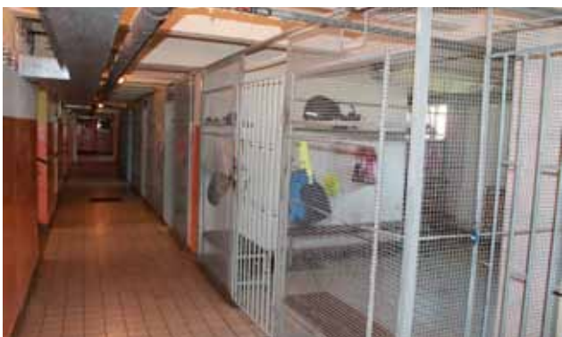
Rekonstrukce šaten - starý stav
