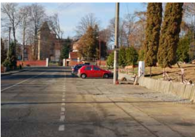
Rekonstrukce křižovatky - starý stav
