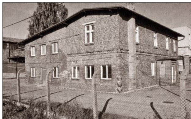
Budova správce továrny v roce 2005
