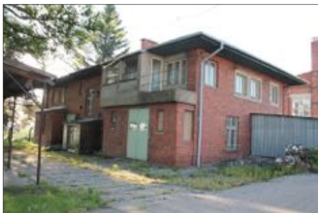
Budova ekonomického úseku v roce 2011
