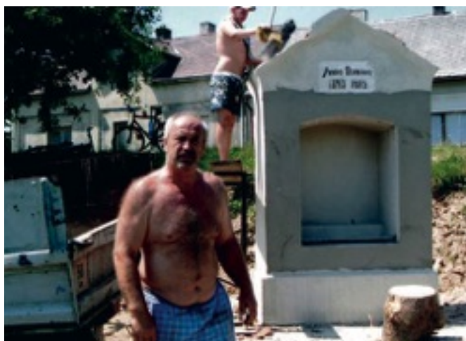
Rekonstrukce v roce 2010
